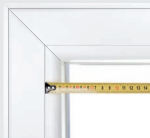
Empfohlener Messpunkt: Glasleistenfuge ggf. auf Beschläge achten
